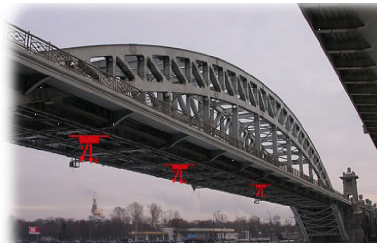
Мал. 10 Контроль стану мостів і опор
