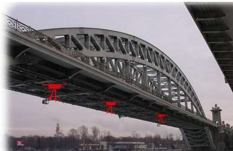
Мал. 10 Контроль стану мостів і опор
