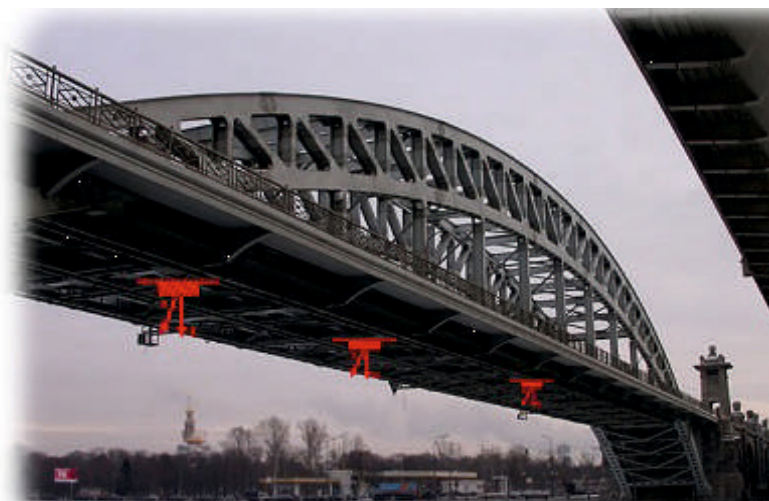
Мал. 10 Контроль стану мостів і опор
